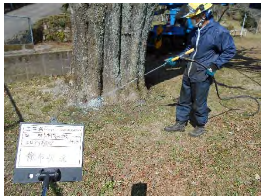
シロアリ駆除剤の散布 (朝陽小学校跡)
