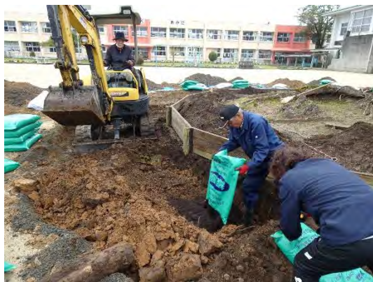
土壌改良材の攪拌 (羽月小学校)
