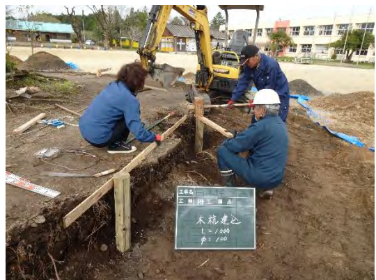
土留柵の設置 (羽月小学校)
