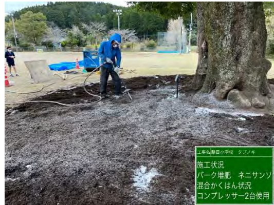
堆肥，土壤改良材の攪拌 (勝目小学校)
