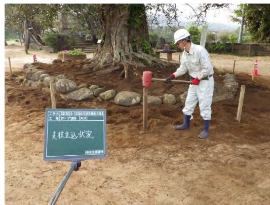
ロープ柵の設置 (榕城小学校)
