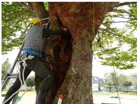
腐朽部位の切削 (霜出小学校)
