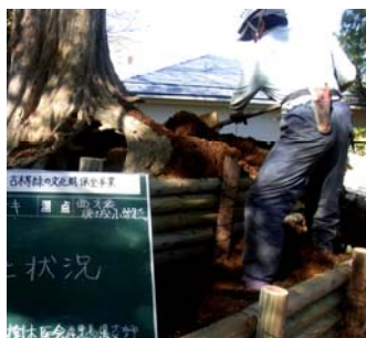
土が流失しないよう木柵を設置し、木の生育に適した土を入れます
