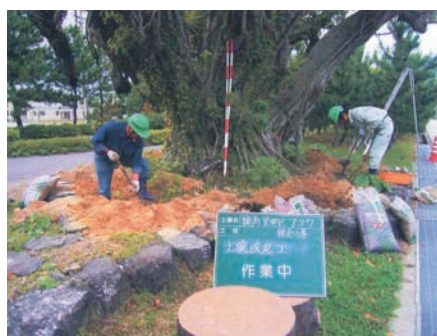
土壌改良施工中
