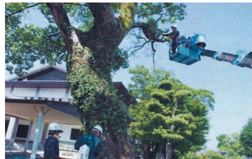
高所作業車によるヤドリギの除去
