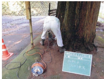
コンクリート舗装のハツリ工事
