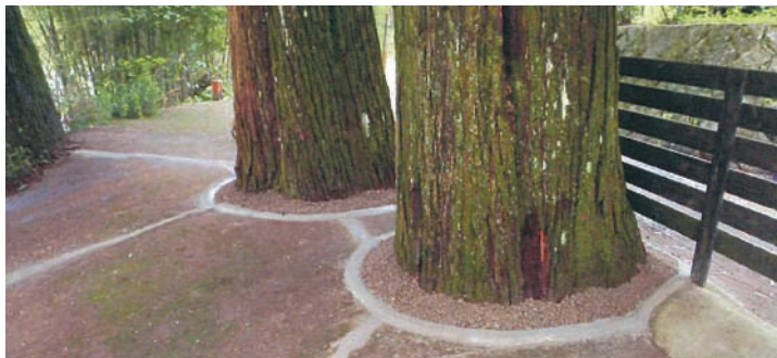
保全工事の完成
