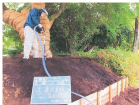
土壌改良工事の状況
