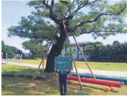
保全工事の完成
