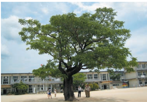
校庭中央にあるセンダンの木の保全工事
