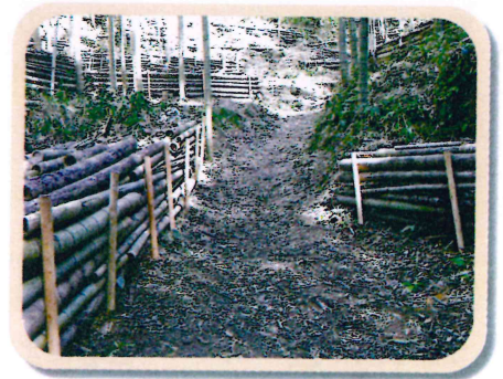
作業用道路の開設
