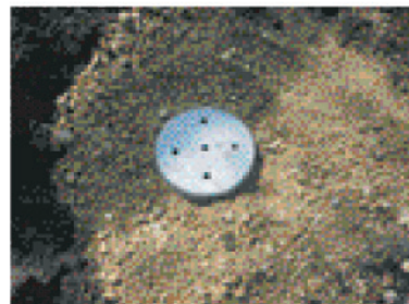
土中に空気を循環させるパイプを埋設し…
