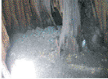
腐れを取り除いて防腐処理をし、ウ口の底面の土壌環境改善などをし、補強を施した上で…
